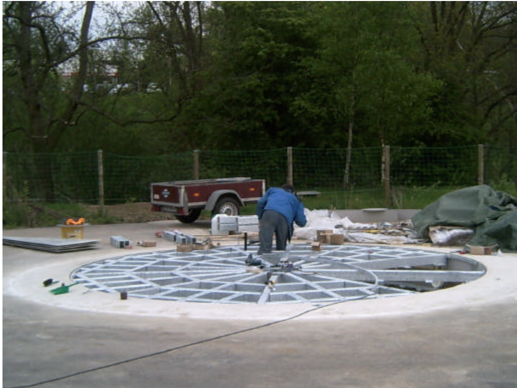
Outdoor-Turntable: \phi 4,5 m; 5to Nutzlast; Drehgeschwindigkeit 1 .. 4 \text{min}^{-1} ; Positioniergenauigkeit \pm 0,1^\circ
